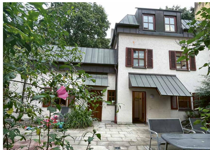
Zwölf Monate dauerte die Sanierung im Haus Karolina.
